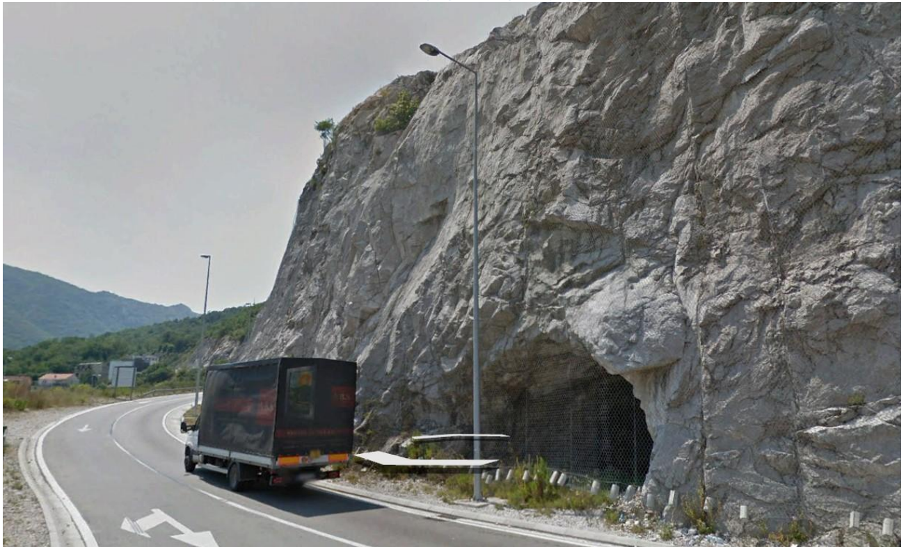
Pogled na lokaciju
